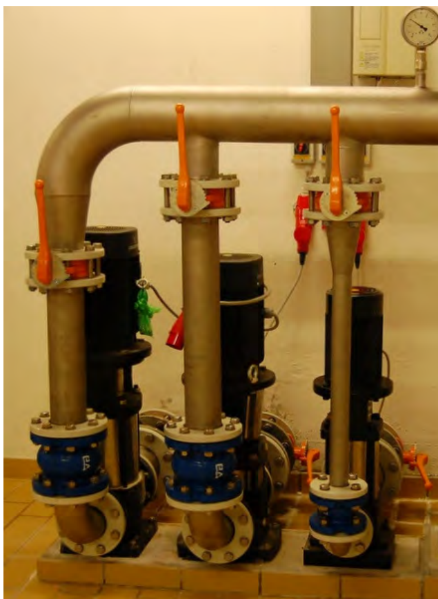
Pumper til at pumpe rent drikkevand ud til forbrugerne efter behandling på vandværket.
