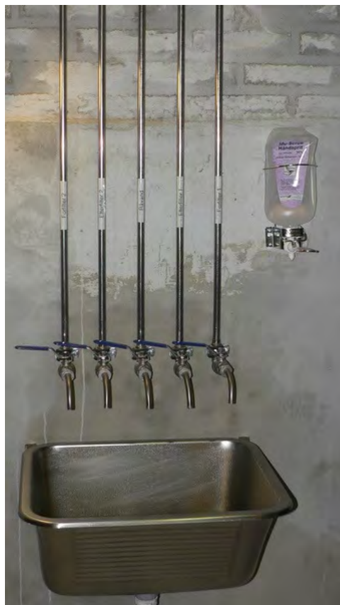
Prøvetagningssted på et vandværk. Læg mærke til sprit-beholderen til desinfektion af haner og hænder før prøvetagning.
